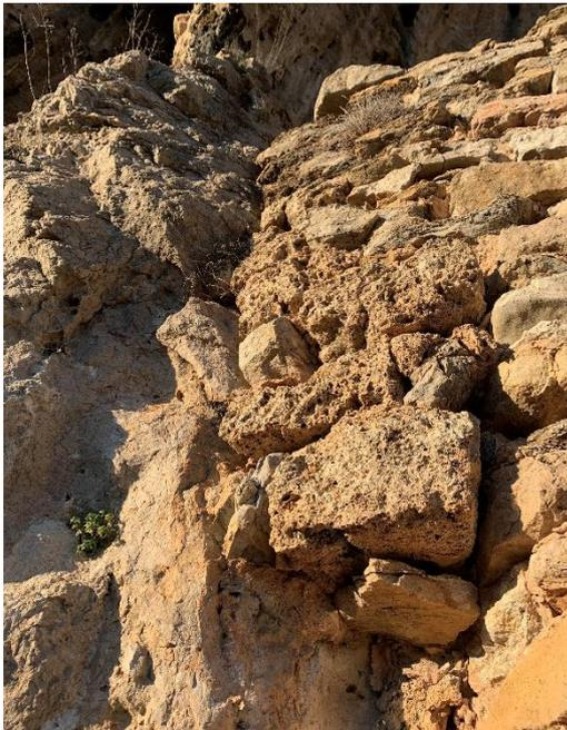
*Fig. 3 Parement externe du mur barrant la grotte est – moellons en tuf et coup de sabre, dégradation en sous-œuvre – Image Denis Langlois*
