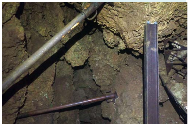
▼ Salvage etayage (photo Caillou)
